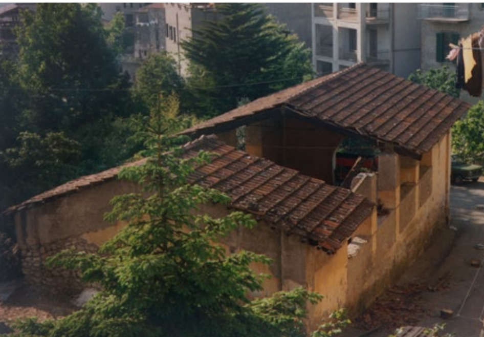
Rara immagine del secondo Lavatoio di Moricone, prima della demolizione: era alimentato con le acque dell'acquedotto Le Capore .
