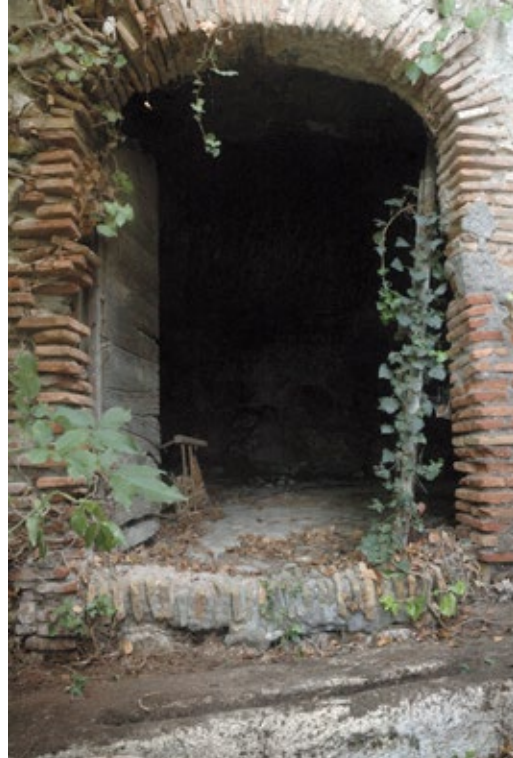
Tunnel sotterraneo del "Fruzzo", per il passaggio dell'acqua quale forza motrice, ed entrata al maggior locale del fabbricato, visibile sotto.
