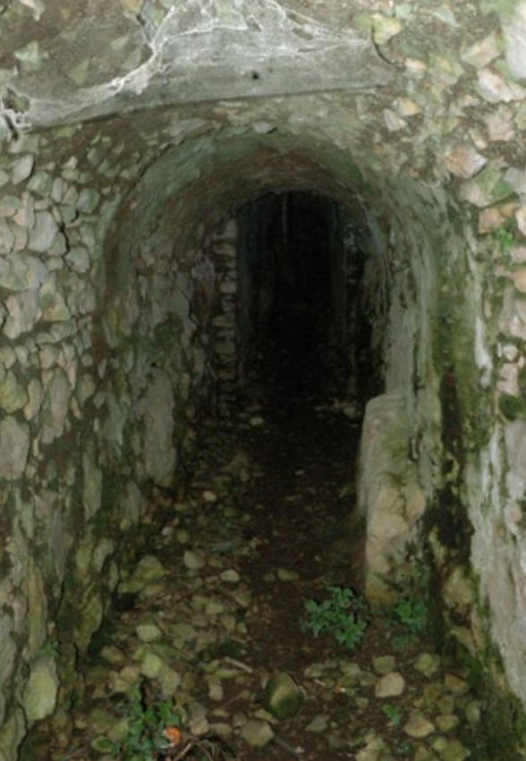
Tunnel sotterraneo del "Fruzzo", per il passaggio dell'acqua quale forza motrice, ed entrata al maggior locale del fabbricato, visibile sotto.
