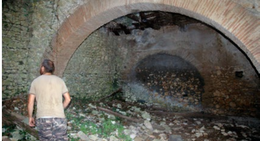
Prima Mola di Casoli: sulla soglia, formata da una mezza macina in pietra, e interno del mulino. Sotto: Nell'angolo, tre macine sovrapposte.
